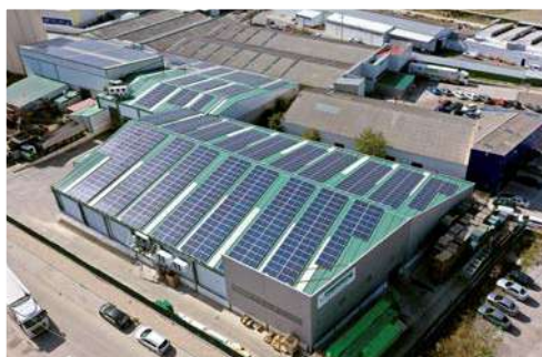
Instalación solar fotovoltaica en industria hortícola de Cuéllar.
